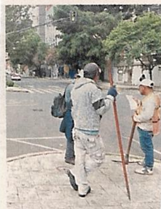
Trabajadores ya alistan las obras con mediciones.
