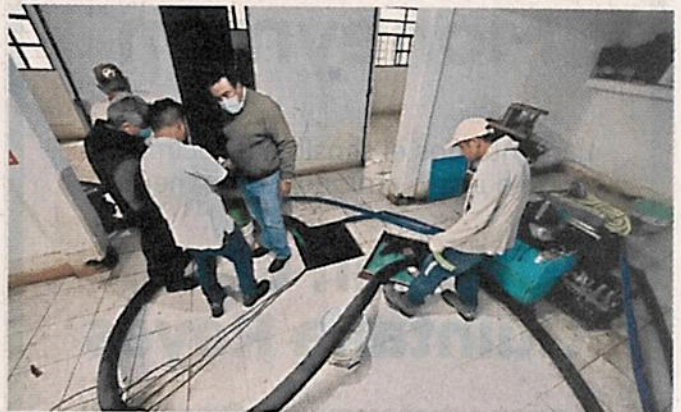
Personal de la Alcaldía y del Sacmex extraen el agua con bombas que operan hasta por 10 horas.
