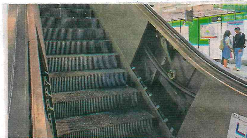
En las escaleras mecánicas se refleja el paso de los años, pues están en mantenimiento o llenas de polvo y basura.
