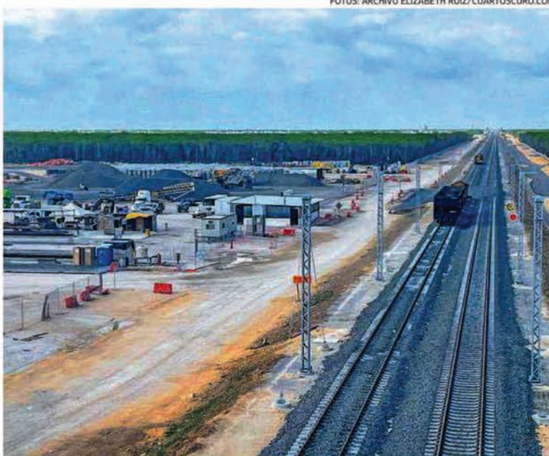
Continúa la construcción del Tramo 5 del Tren Maya en Playa del Carmen
