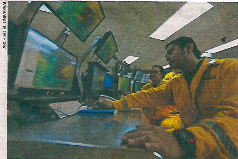
Si Pemex pierde por ejemplo el control para monitorear ductos, puede sufrir un cierre parcial de operaciones, opina un especialista.
