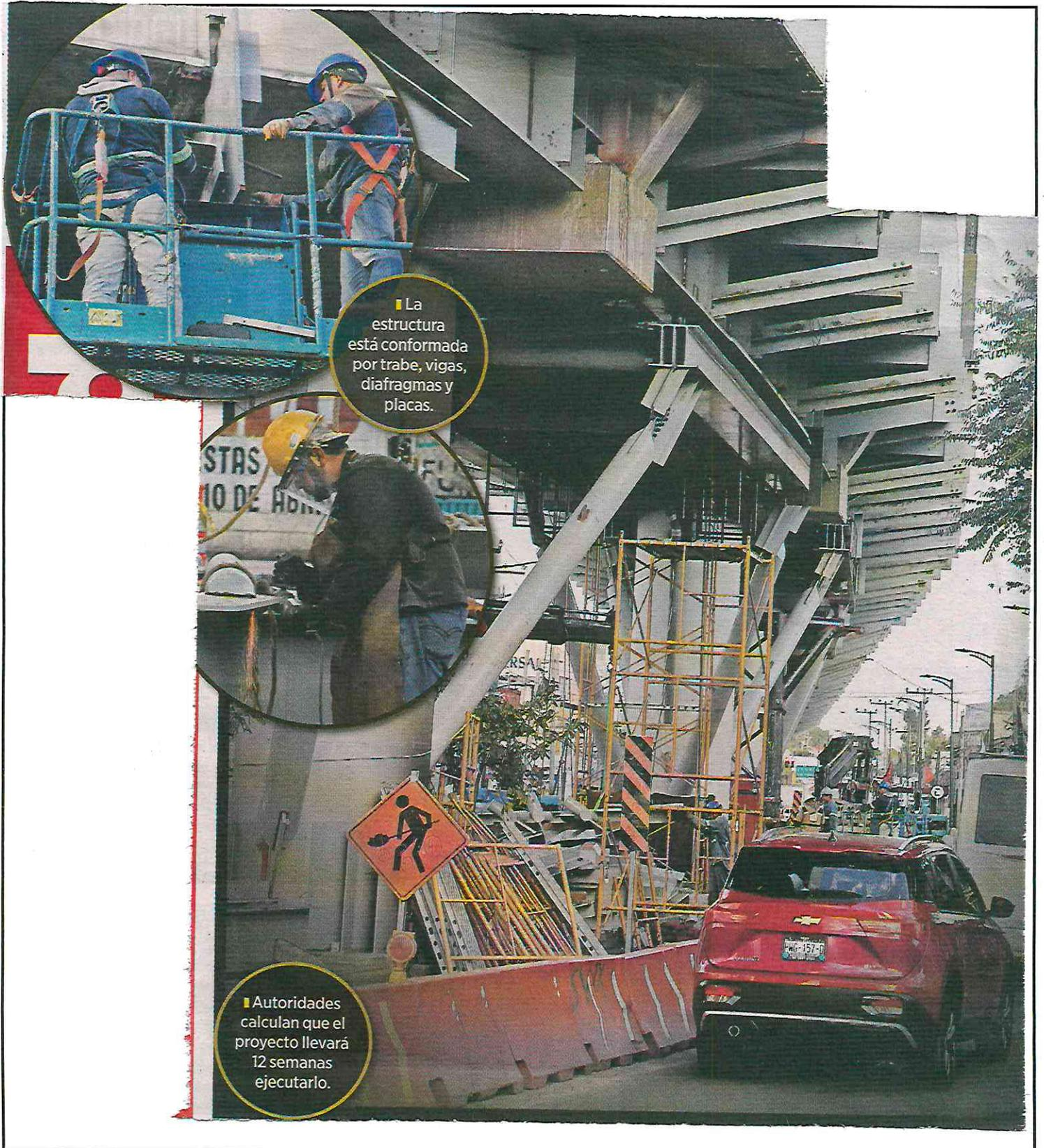
La estructura está conformada por trabe, vigas, diafragmas y placas.
