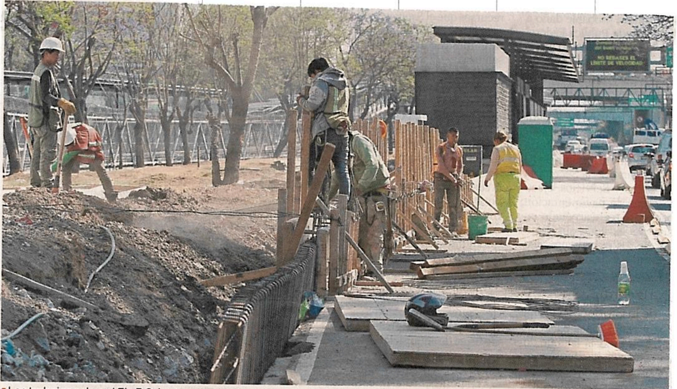
Los trabajos sobre el Eje 3 Oriente comenzaron en agosto de 2017 y terminarán en abril, de acuerdo con la Secretaría de Obras.
