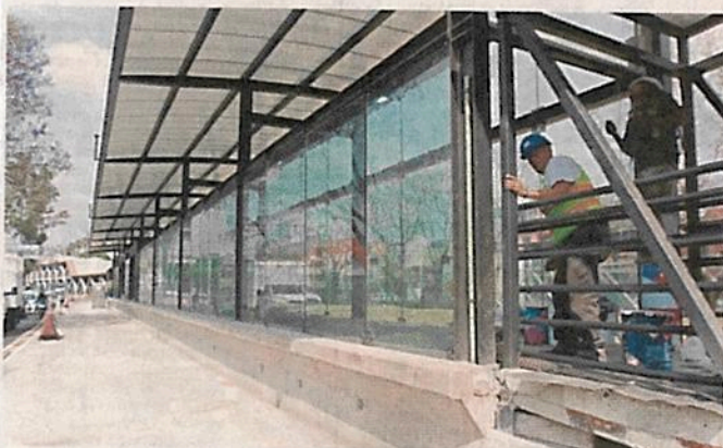
La mayoría de las estaciones proyectadas va tomando forma, pero tres de ellas apenas comenzaron a ser construidas.
