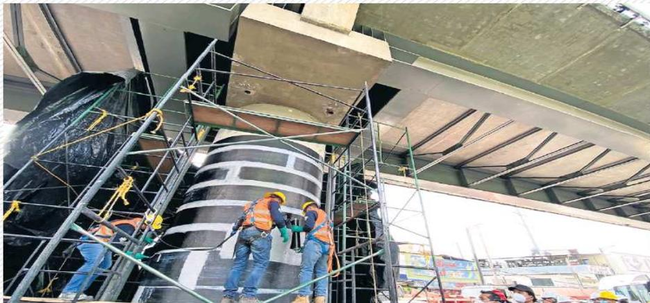
Hasta el momento, en el tramo entre las estaciones Tezonco y Periférico Oriente, 66 columnas han sido intervenidas con inyección de grietas y 30 con fibras de carbono, detalló la Secretaría de Obras.
