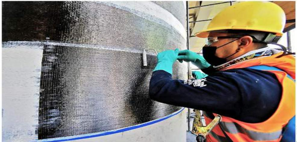
PROCESO. El reforzamiento consiste en rellenar con resina, mediante fibras de carbono y colocando puertos en las grietas.
