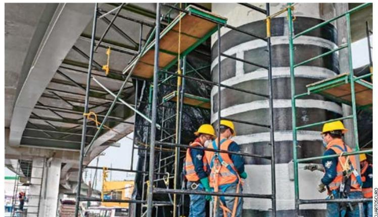
**LABOR.** En las columnas se trabaja en la inyección de grietas para reforzar el concreto, mientras se espera la llegada de estructuras metálicas.
