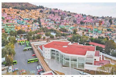
La construcción del hospital en la colonia Pastora lleva detenidos dos años. Ante la emergencia sanitaria, se prevé que este listo, a más tardar, el 28 de febrero.
