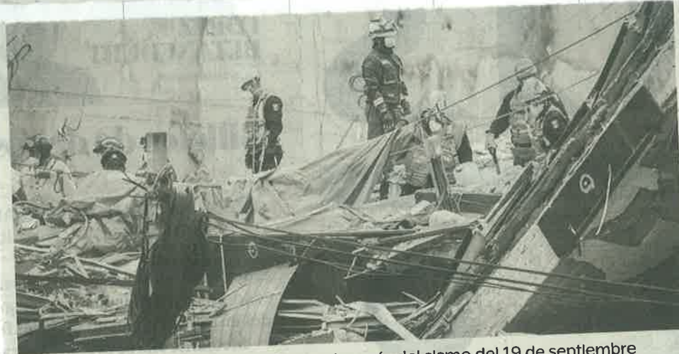
Aún falta mucho para la reconstrucción después del sismo del 19 de septiembre
