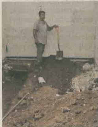
■ También se construyen locales de concreto.
