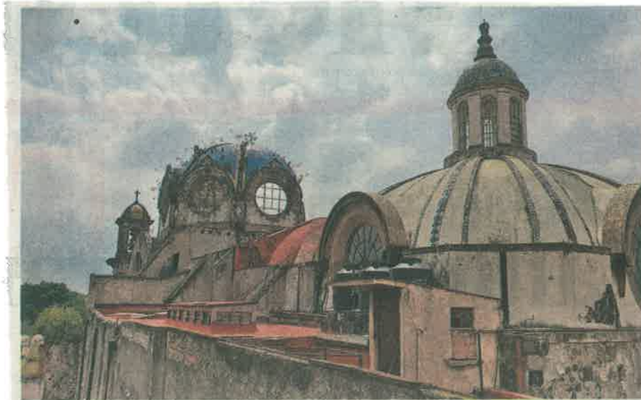
La Arquidiócesis Primada de México externó su interés para la pronta restauración de los inmuebles afectados /FOTO: ESPECIAL
