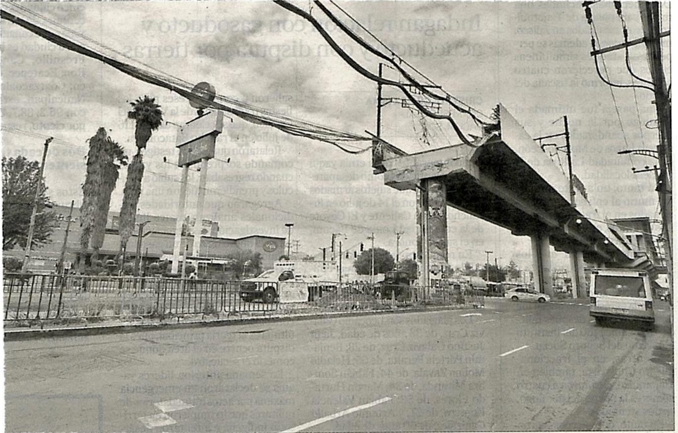
▲ Aspecto de la llamada "zona cero", donde el 3 de mayo pasado colapsó una trabe de la línea 12 del Metro, entre las estaciones Tezonco y Olivo, sobre avenida Tláhuac, con saldo de 26 muertos y más de 100 lesionados. Foto Cristina Rodríguez
