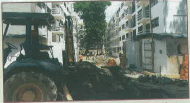
Una de las obras con mayor porcentaje de avance actualmente.
