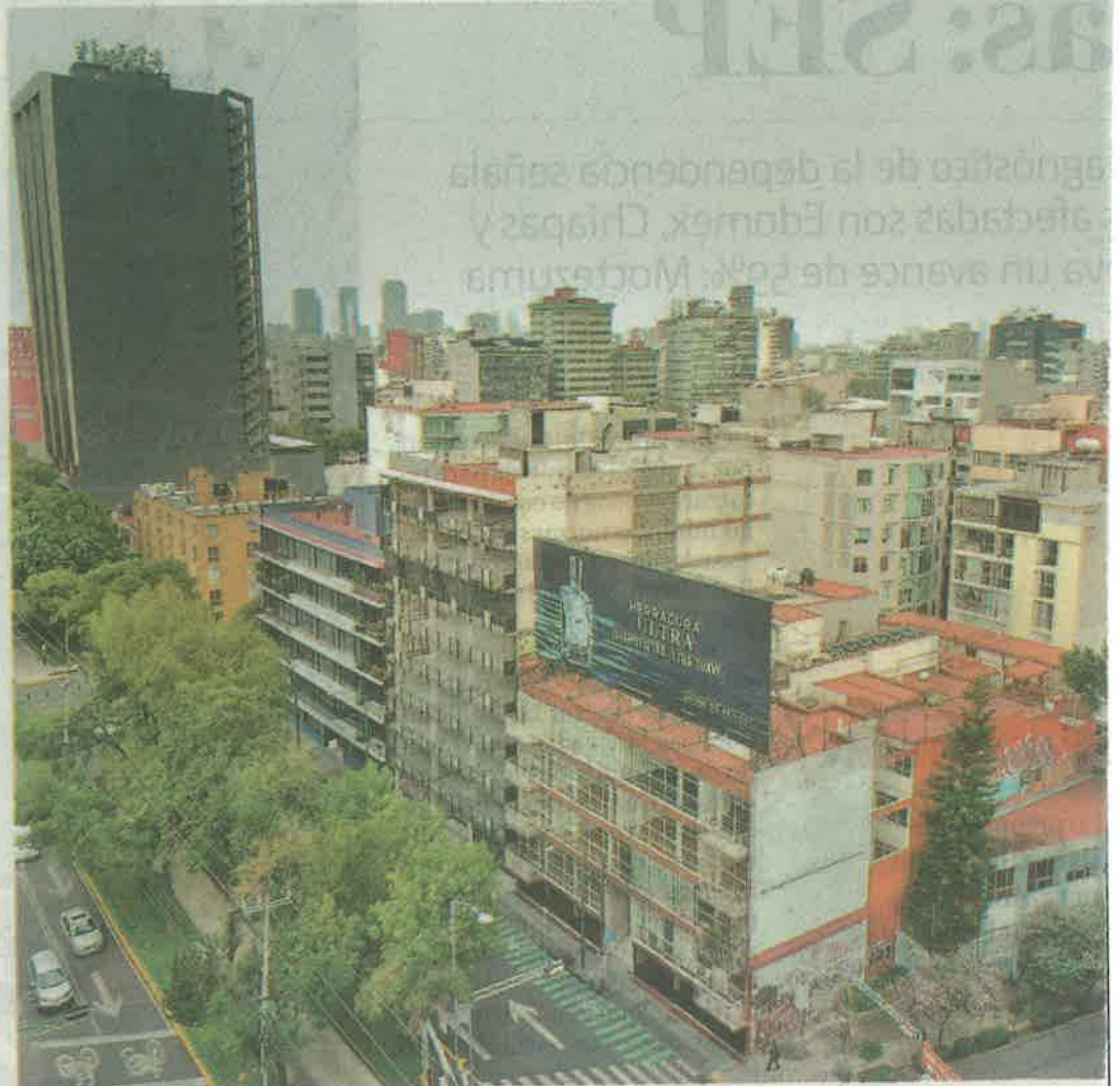
La estructura ya fue retirada del inmueble (edificio a un lado del espectacular). OMAR FRANCO
