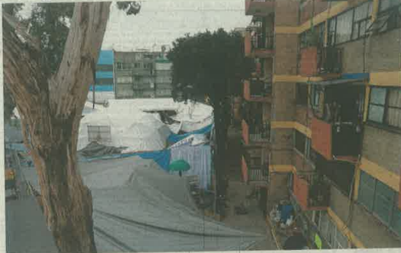
Habitantes del multifamiliar montaron campamentos afuera de sus edificios para vigilar los avances en las obras de rehabilitación en octubre de 2017.
