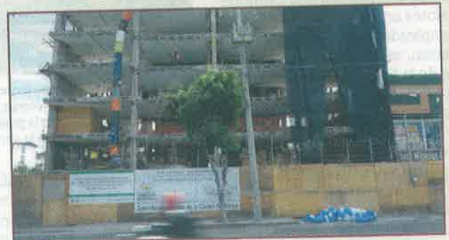
Algunas edificaciones en la colonia tienen progreso evidente.
