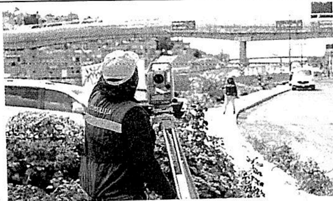
La obra del puente vehicular ya comenzó y modificará la convivencia entre conductores y entre vecinos.
