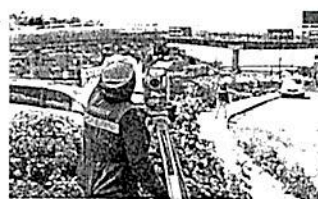
La obra del puente vehicular ya comenzó y modificará la convivencia entre conductores y entre vecinos.
