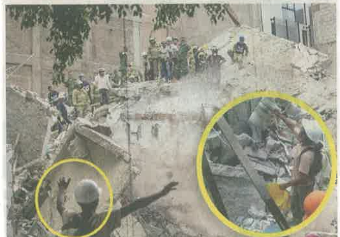
■ Johnnatan Rivas fue uno de los albañiles que ayudó a retirar escombros de los edificios colapsados.
