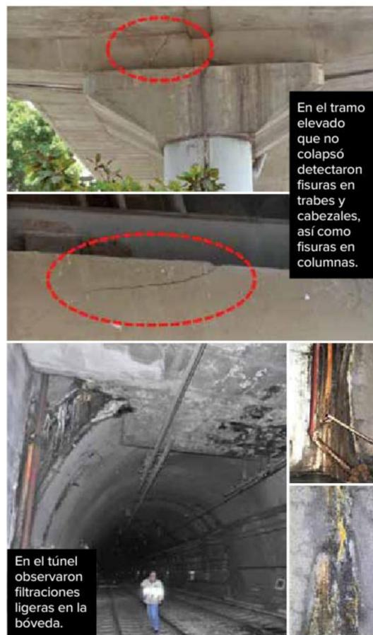
En el tramo elevado que no colapsó detectaron fisuras en traveses y cabezales, así como fisuras en columnas.
