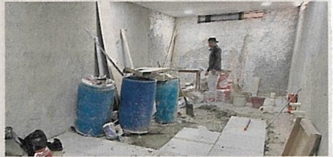
Las obras estuvieron detenidas durante tres meses.
