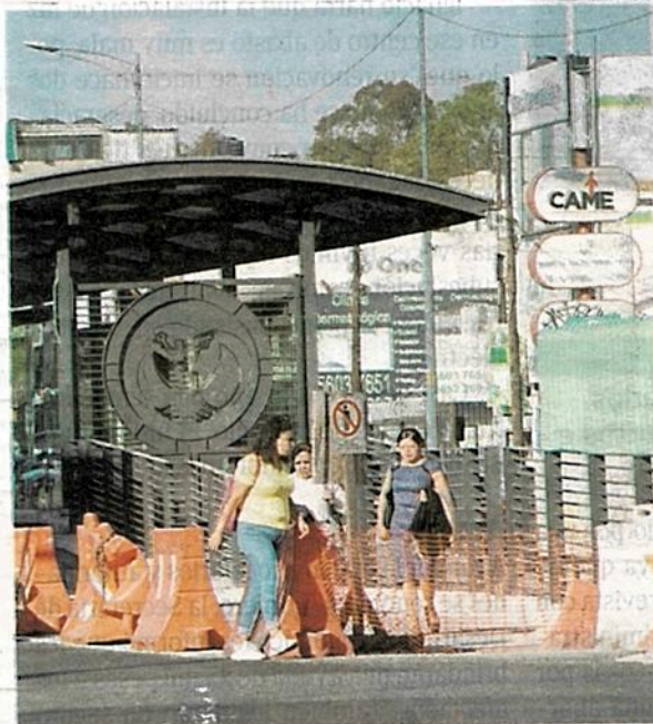
Sólo las obras cercanas a San Lázaro están en un punto de arranque/ERNESTO MUÑOZ
