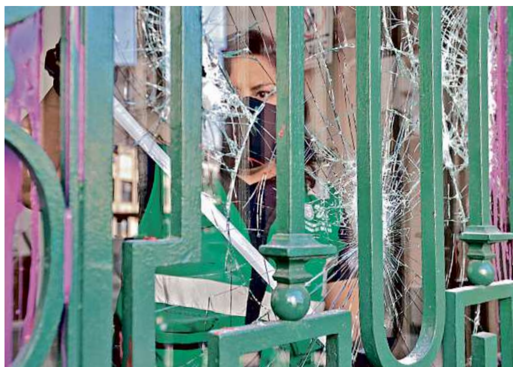
Los daños sólo fueron en la fachada, escalinatas, puertas y escalinatas del Congreso.
