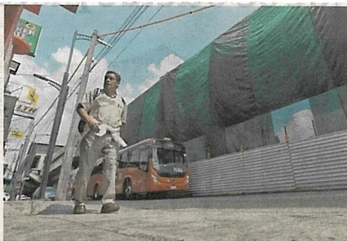
La jefa de Gobierno anunció que el tramo gemelo de L12 se tiene que demoler y reconstruir. Actualmente está cubierto por una lona verde.
