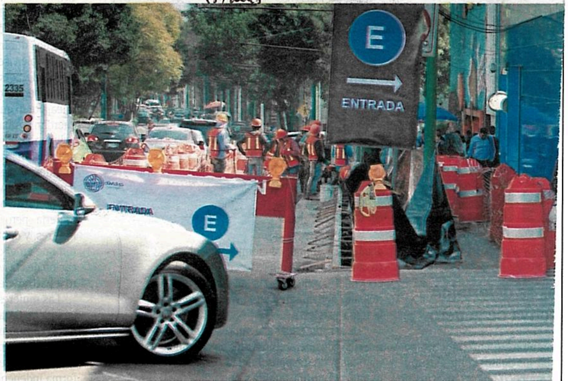
Está en desarrollo la renovación de la banqueta en el lado sur/FOTOS: ROBERTO HERNÁNDEZ
