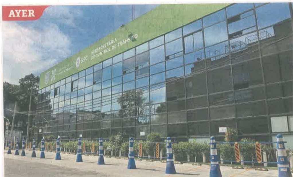
BARRERA. La banqueta de la Avenida Obrero Mundial es resguardada con trafilambos.
