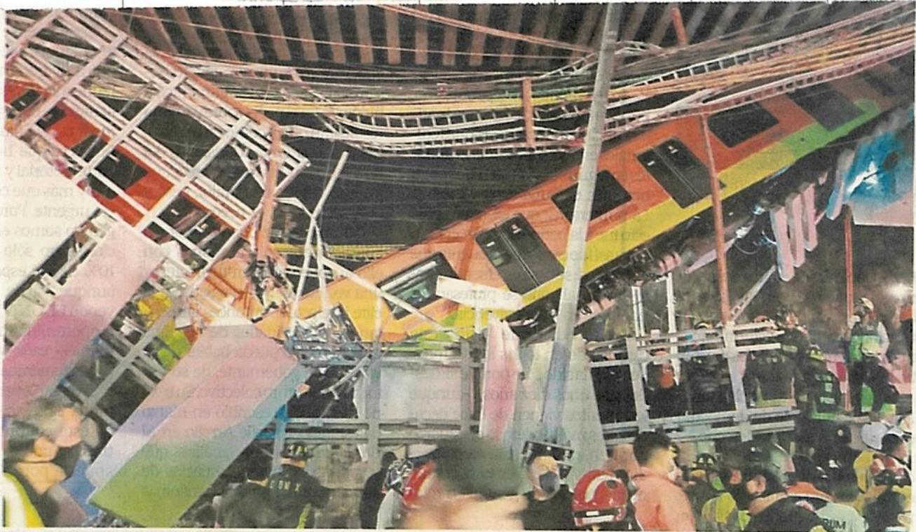
Los dos peritajes de la noruega DNV y el informe de la FGJ coinciden en que errores en construcción provocaron el colapso.
