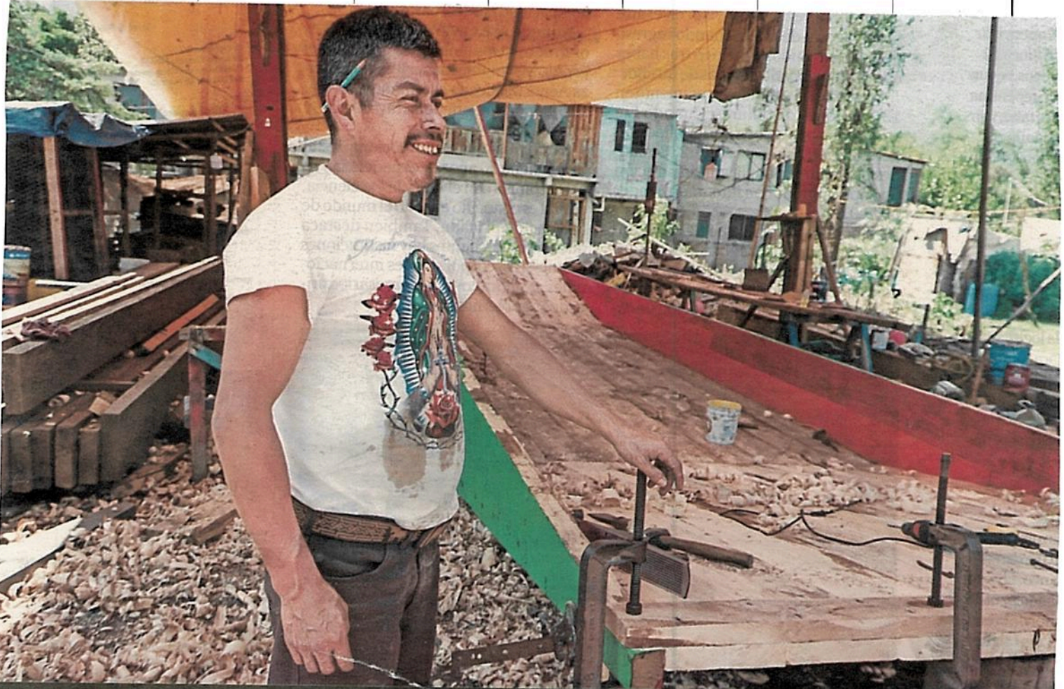
NAVIERO CAPITALINO. Heredero de una tradición prehispánica, José Téllez es uno de los constructores de trajineras que hoy navegan por los canales de Xochimilco CDMX.P.8
