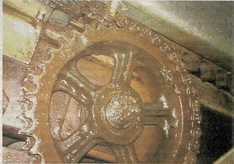
El Metro de la Ciudad de México difundió imágenes de piezas oxidadas por los orines y que provocan averías en el sistema mecánico.
