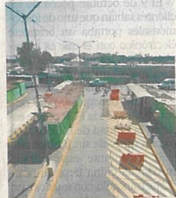
Las autoridades no quieren someter a más carga la estructura del sótano.
