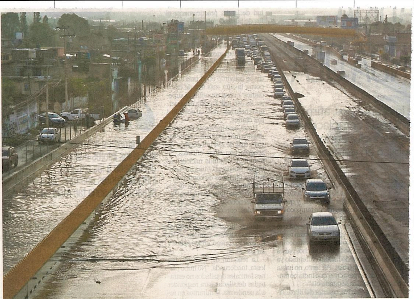
La autopista México-Puebla estuvo cerrada varias horas debido a las inundaciones en unos tramos.
