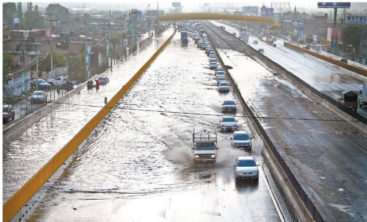
La autopista México-Puebla estuvo cerrada varias horas debido a las inundaciones en unos tramos.
