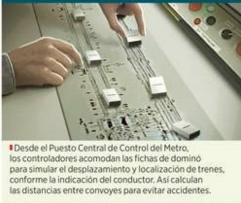
Desde el Puesto Central de Control del Metro, los controladores acomodan las fichas de dominó para simular el desplazamiento y localización de trenes, conforme la indicación del conductor. Así calculan las distancias entre convoyes para evitar accidentes.
