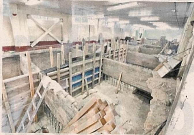
■ Algunas escuelas necesitaron reparaciones mayores debido al estado en el que estaban por el confinamiento.
