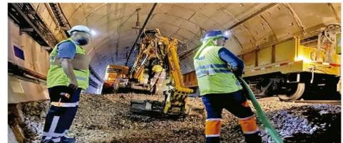
Con una retroexcavadora se retiró el balasto en mal estado para reforzar la subbase y luego colocar balasto de mayor dureza.
