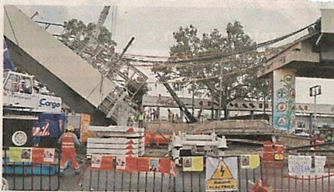
Los trabajos de limpieza en la zona del colapso continuaron ayer.
