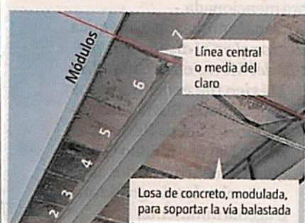
Posibles causas que colaboraron en falla de estructura Añadido al subdiseño de las traves
