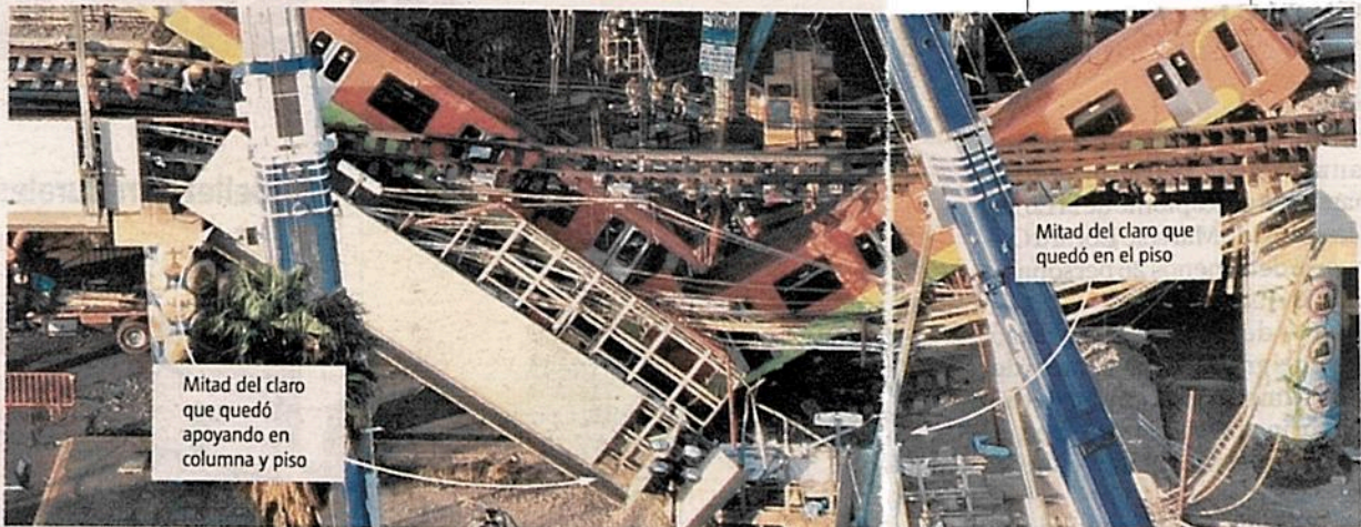
Módulos de la trabe Vista general inferior del claro
