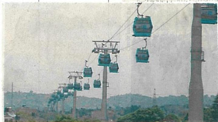
La Línea 1 del Cablebús tiene un sistema de monitoreo del cable las 24 horas del día, destacó la empresa operadora Doppelmayr.
