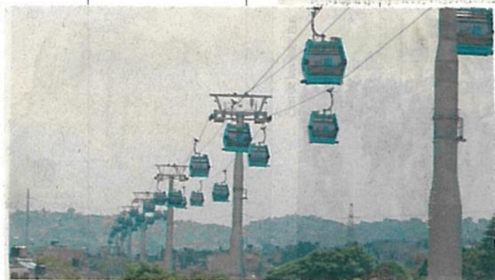
La Línea 1 del Cablebús tiene un sistema de monitoreo del cable las 24 horas del día, destacó la empresa operadora Doppelmayr.
