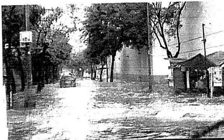
La alcaldía de Iztapalapa tuvo daños en dos colonias.
