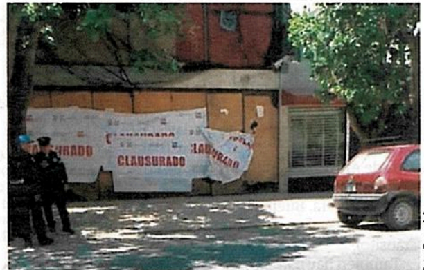
EL INMUEBLE está en proceso de ser demolido; investigan a los agentes que realizaron el cateo.
