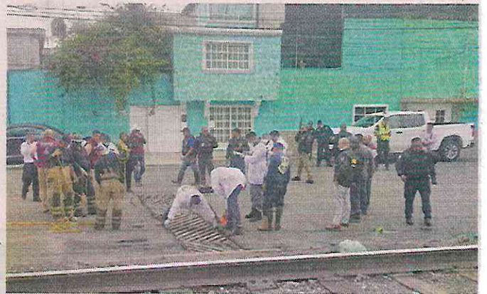
Personal de Petróleos Mexicanos acudió y realizó limpieza en los ductos del drenaje situados bajo la Vía Tapo.
