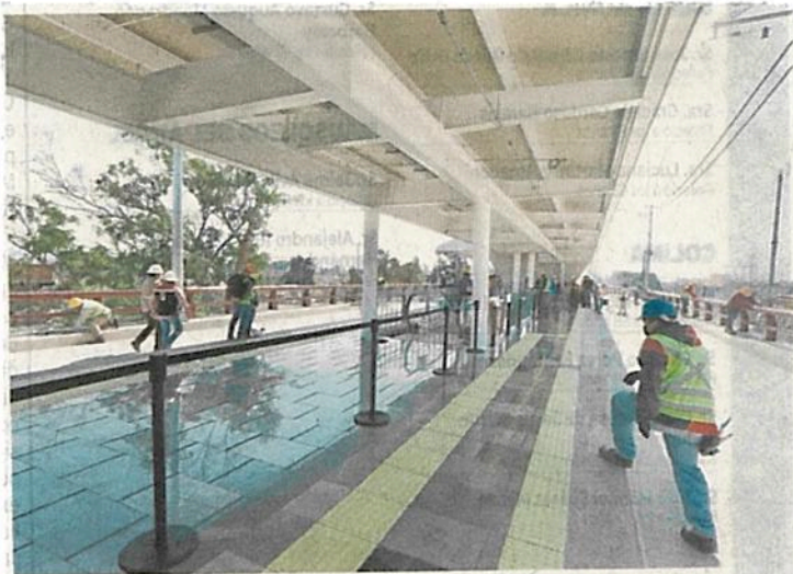
El Trolebús Elevado Ermita-Iztapalapa tiene una longitud de 7.4 kilómetros para nueve estaciones intermedias y dos terminales.
