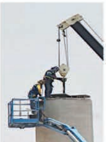
Las obras del Interurbano suman más de 10 años.
