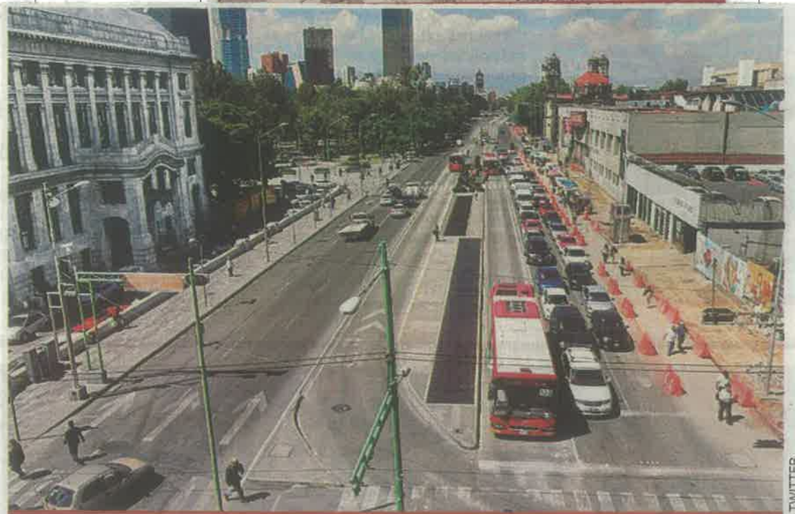
Se invertirán 48 millones de pesos para la rehabilitación de 31 mil 688 m 2 de la avenida.
