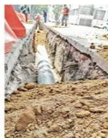
Las obras se realizaron en la interconexión del acueducto Chalco-Xochimilco.
