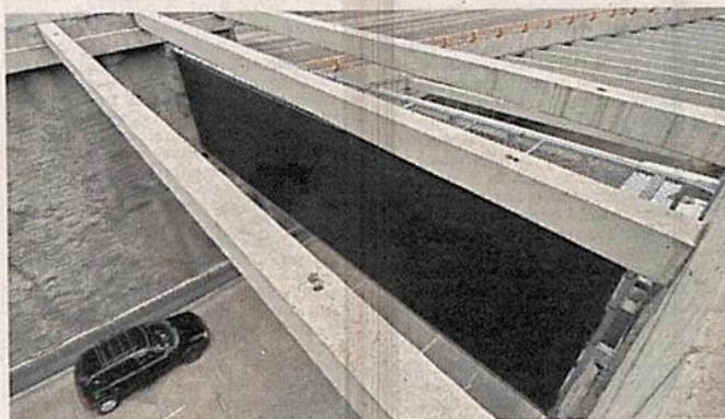
■ Las trabes estructurales soportan las pantallas electrónicas.
