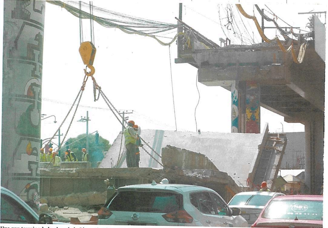
Una vez terminada la obra de la Línea 12, a las autoridades se les entregó un manual sobre cómo realizar el mantenimiento, refirió el abogado Alejandro Romano.
