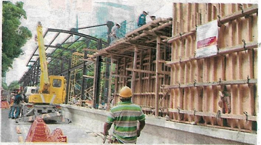
En Insurgentes los trabajos se permiten por ser obra pública/FEDERICO XOLOCOTZI
