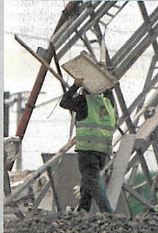
Personal de la Gerencia de Obras y Mantenimiento trabajarán las 24 horas del día.
