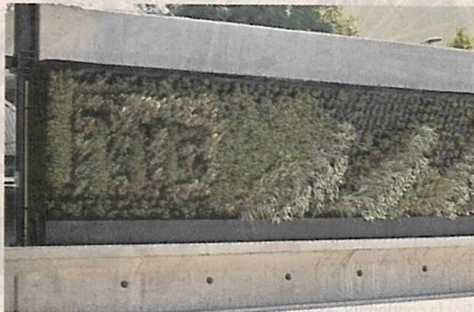
En algunas estaciones de la ampliación comenzaron a colocarse ya los muros verdes.
