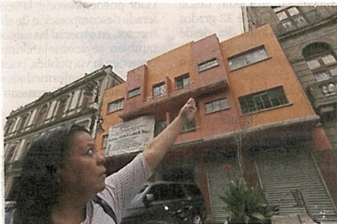
■ Esmeralda muestra el edificio. La falta de una fianza que garantice que no habrá daños tiene trabado todo.
