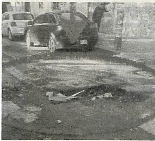
El hoyo ya rebasó el metro de ancho
