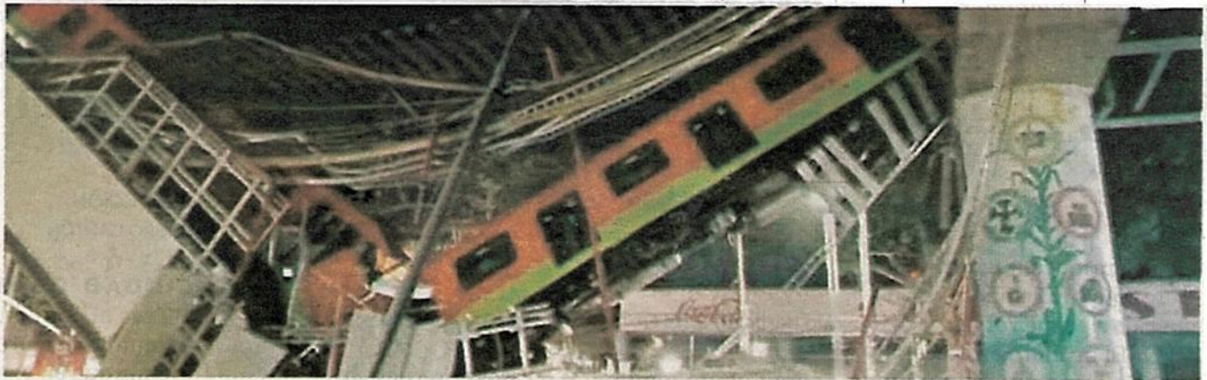
En la obra civil, fue donde se dio la falla, afirman trabajadores
