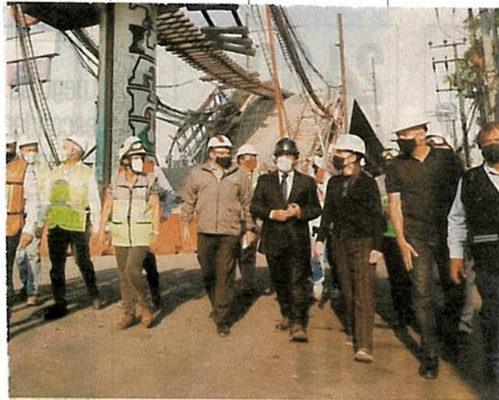
La jefa de Gobierno, Claudia Sheinbaum (tercera de der. a izq.), acudió por la tarde para supervisar las obras de remoción.
