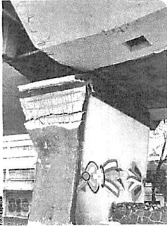
LA LÍNEA 4 DEL METRO, EN CONSULADO.
