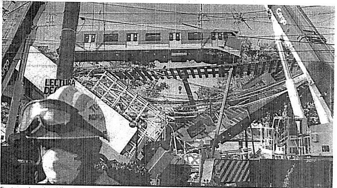
Gigantescas grúas movieron del lugar del accidente a los dos vagones desplomados de la Línea 12 en la estación Olivos
