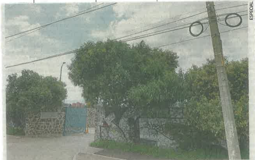
El robo de cables ocurrió en el Laboratorio de Estructuras y Materiales de Alta Tecnología y en un deportivo de la UNAM.
